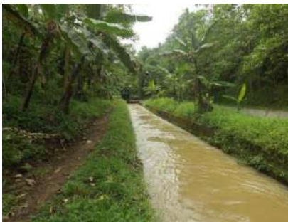
Gambar 3. 3 Saluran Penghantar Terbuka PLTA Ubrug
