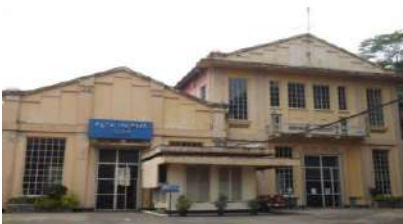
Gambar 3. 9 Bangunan Pembangkit (Power House) PLTA Ubrug
