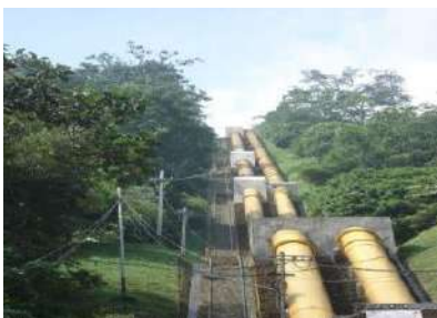
Gambar 2. 21 Pipa pesat (Sumber: PLTA Lamajan)
