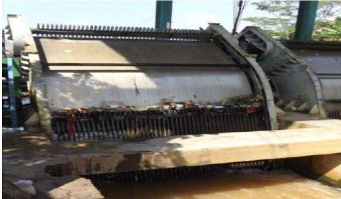
Gambar 2. 10 Automatic Trash Rake di PLTA Ubrug, Sukabumi
