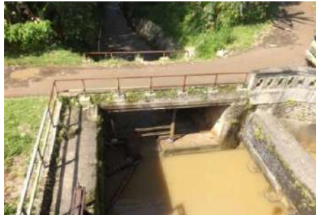
Gambar 3. 5 Saluran Pelimpah PLTA Ubrug
