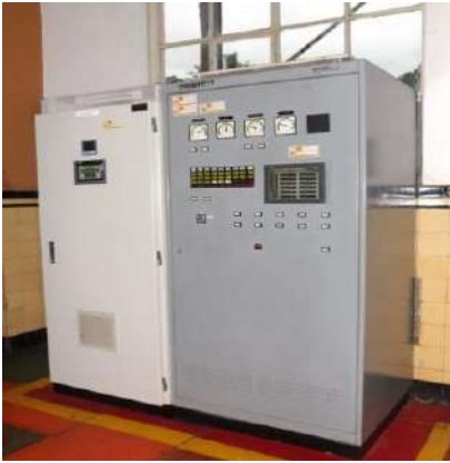
Gambar 2. 34 AVR pada Sistem PLTA Ubrug (Sumber: Hasil survei Eka Nur Ajiz, November 2016)
