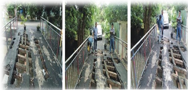
Gambar 26. Jembatan Pondok Karya 10
