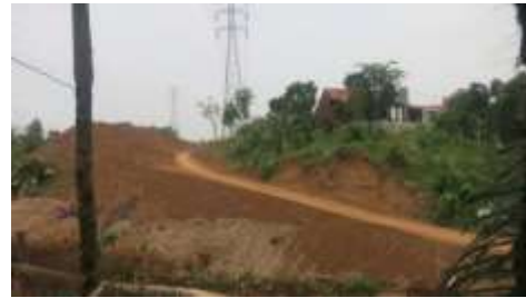
Gambar 8. Kondisi lahan kategori kritis di Kelurahan Katulampa pada pembangunan terusan Jalan Pandu Raya
